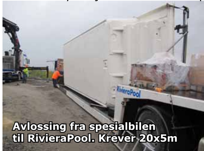
Bassenget heises på plass med egen kranbil.
